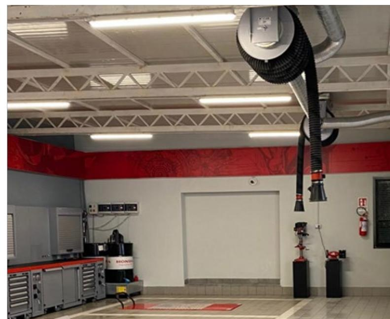
ASPIRAZIONE GAS DI SCARICO | EXHAUST FUME EXTRACTION | ASPIRATION DES GAZ D'ÉCHAPPEMENT | ABGASABSAUGUNG | ASPIRACIÓN DE GASES DE ESCAPE
